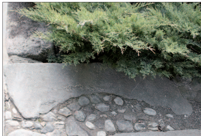
6. Le linteau démonté et réemployé dans le pavage du parvis. (G. Sartorio)
