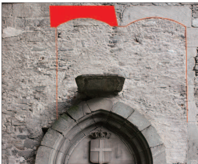
5. Façade Ouest de la chapelle d'Ybleto de Challant, avec la position hypothétique du deuxième linteau, utilisé aujourd'hui dans le pavage du parvis. (G. Sartorio)
