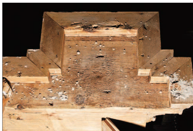
15. Le colature di gesso sono presenti su tutta la struttura: nell'immagine, la parte superiore della trabeazione del tempietto destro. (Pm. Reboulaz)
