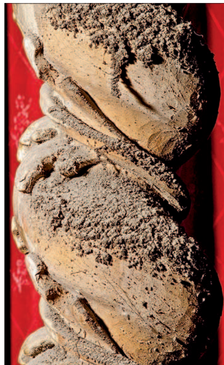
2. Ingenti depositi di polvere su una colonna del primo ordine. (Pm. Reboulaz)
