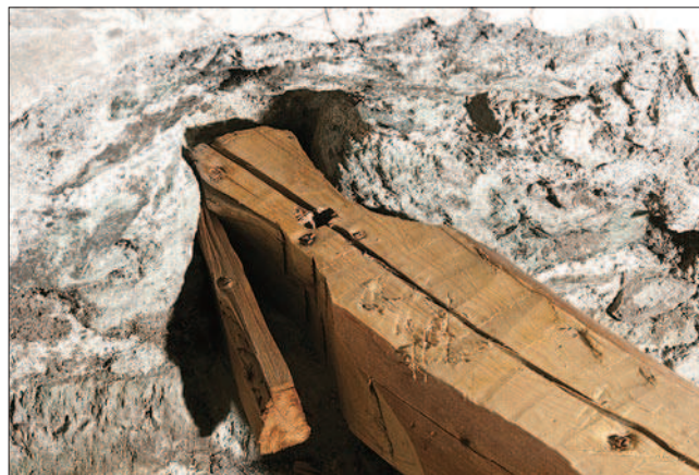
12. L'ancoraggio va ad incastrarsi tra le pietre dell'abside. (Pm. Reboulaz)
