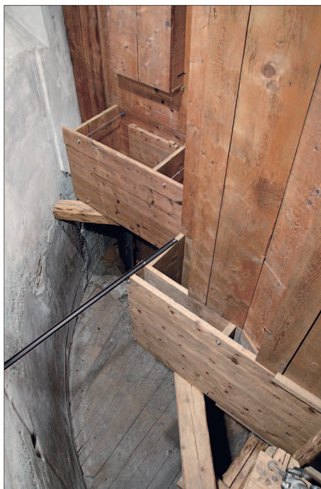
10. Parte destra della cassaforma di base. (Pm. Reboulaz)
