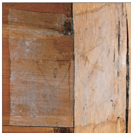
9. Simboli di assemblaggio delle parti rinvenuti nei punti di giunzione. (Pm. Reboulaz)
