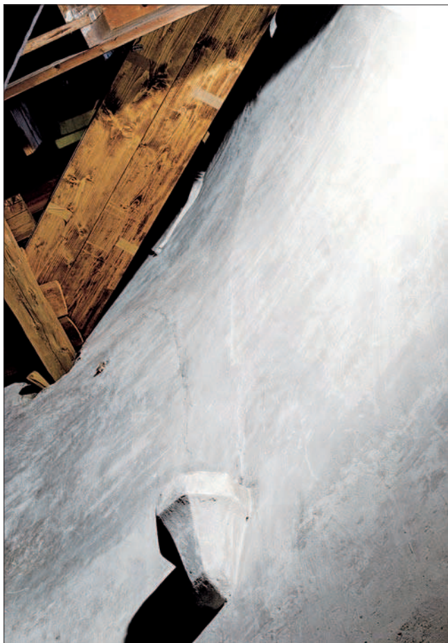
16. L'imposta della volta antica è ancora ben visibile sopra il capitello pensile in pietra. (Pm. Reboulaz)
