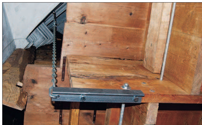
8. Dettaglio sulle parti metalliche applicate a rinforzo e sostegno della struttura lignea. (Pm. Reboulaz)
