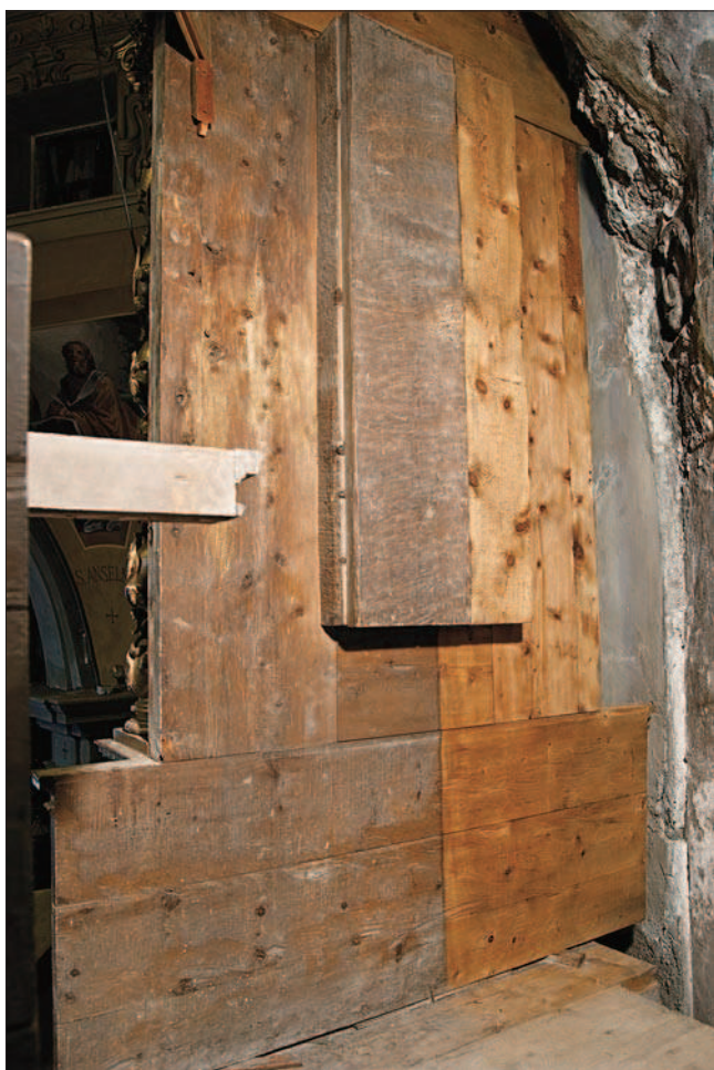
7. Fase di lavaggio della struttura posteriore. (Pm. Reboulaz)
