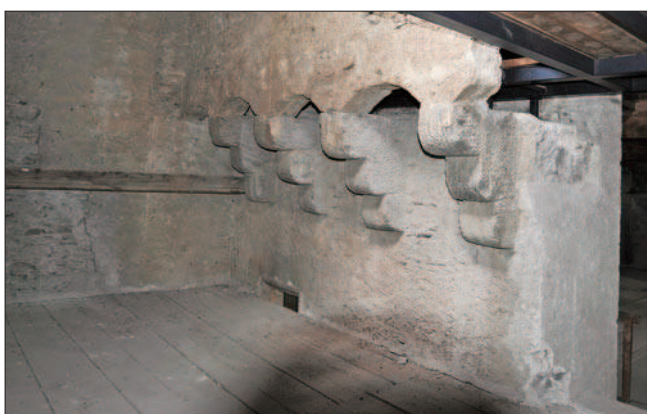
5. Piano del sottotetto, vano verso settentrione, particolare delle mensole in bardiglio del sistema di coronamento merlato dell'antico donjon. (F. Filippi)
