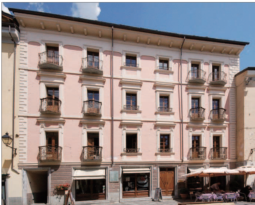
1. Vista della Maison Barillier. (A. Novel)
