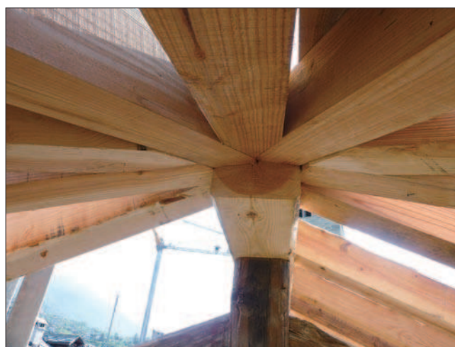
3. Particolare nodo di appoggio dopo l'intervento. (C. Avantey)
