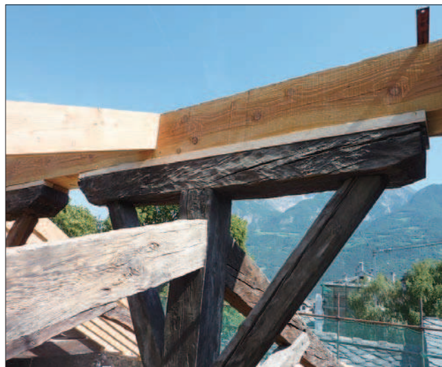
4. Particolare nuovo colmo su capriata lignea preesistente. (C. Avantey)
