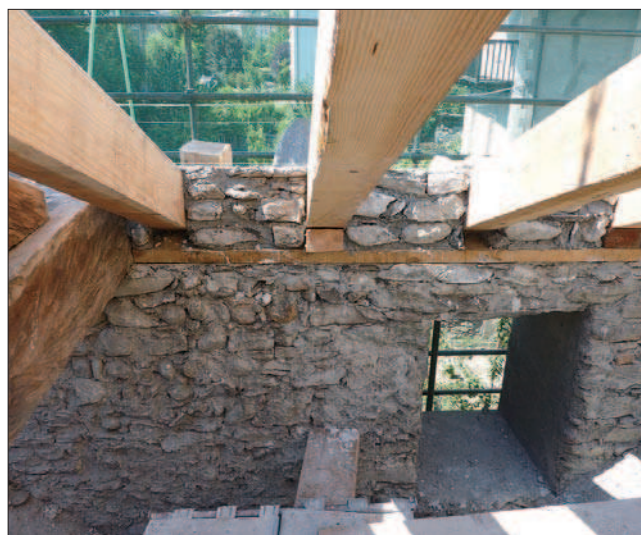
5. Particolare appoggio travi secondarie sulla muratura d'ambito. (C. Avantey)
