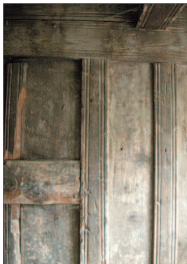
5. La structure à ossature du grenier de Grand-Fauve, Brissogne. 8 prélèvements de mélèze abattus au cours des automnes/hivers de 1457-1458 à 1460-1461. À droite, le sommier du XII e siècle réemployé en cave et soutenu par un poteau central (LRD08/R6024). (C. Remacle)
