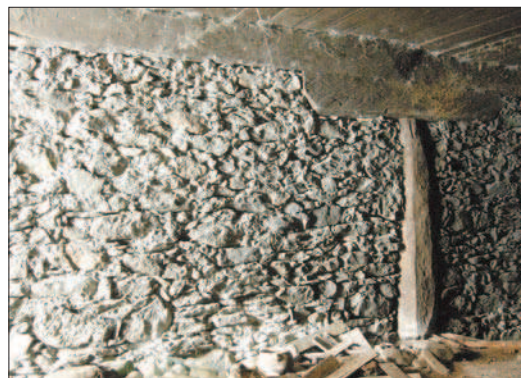
5. La structure à ossature du grenier de Grand-Fauve, Brissogne. 8 prélèvements de mélèze abattus au cours des automnes/hivers de 1457-1458 à 1460-1461. À droite, le sommier du XII e siècle réemployé en cave et soutenu par un poteau central (LRD08/R6024). (C. Remacle)
