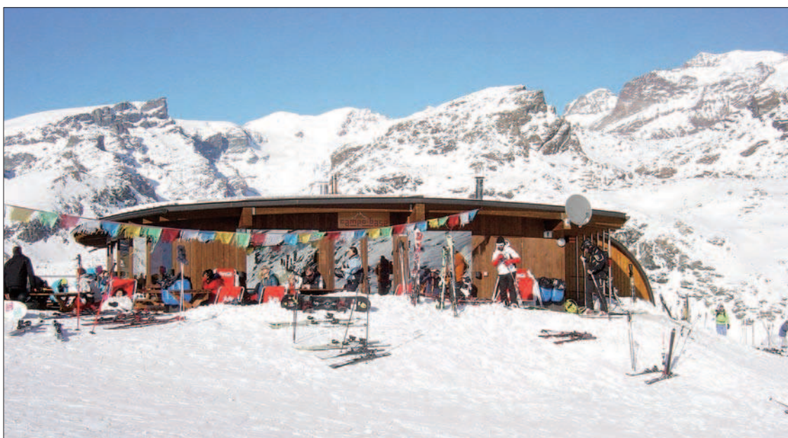
4. Ayas. Ristorante Campo base, vista principale. (M. Maresca)
