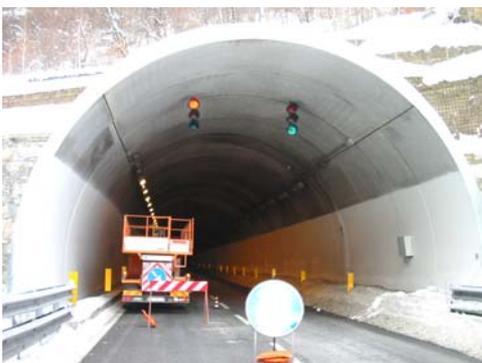
Ad ogni imbocco delle gallerie sono installati dei semafori comandabili solo manualmente in loco. Prima di chiudere una corsia o una carreggiata, gli operatori devono quindi recarsi sul tratto interessato, commutare il o i semafori sul segnale rosso e posizionare i cartelli e pannelli di segnalazione verticali.
