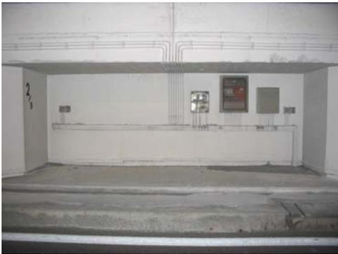
All'interno delle gallerie, sulla destra della corsia di marcia, sono collocate delle nicchie, interdistanziate di circa 300-400 metri, contenenti i quadri elettrici di distribuzione e i sistemi di rilevamento.
