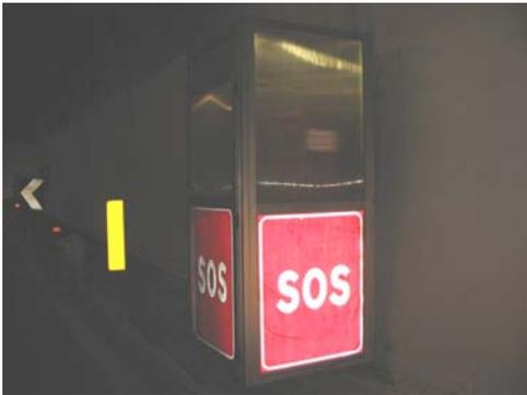
All'interno delle gallerie, alla destra delle corsie di marcia, sono presenti delle piazzole di sosta aventi lunghezza di 80 metri. Il numero delle piazzole dipende dalla lunghezza della galleria (due o tre). In ogni piazzola è presente una cabina SOS.
