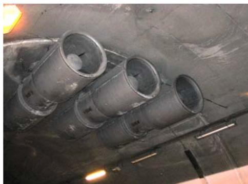
LES CRETES e CHABODEY carreggiata sud), ad un massimo di 26 (galleria di VILLENEUVE carreggiata nord) in funzione della lunghezza e dell'andamento piano altimetrico del tracciato, per un totale di 140 ventilatori.
