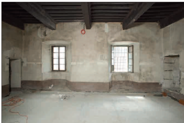
2. La sala al secondo piano del corpo centrale, prima dell'inizio dei lavori di restauro. (S.E. Zanelli)
