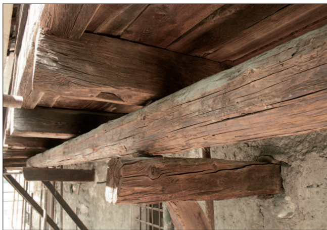
4. Particolare delle travi e delle saette di sostegno della balconata lignea al terzo piano. (M. Cortelazzo)
