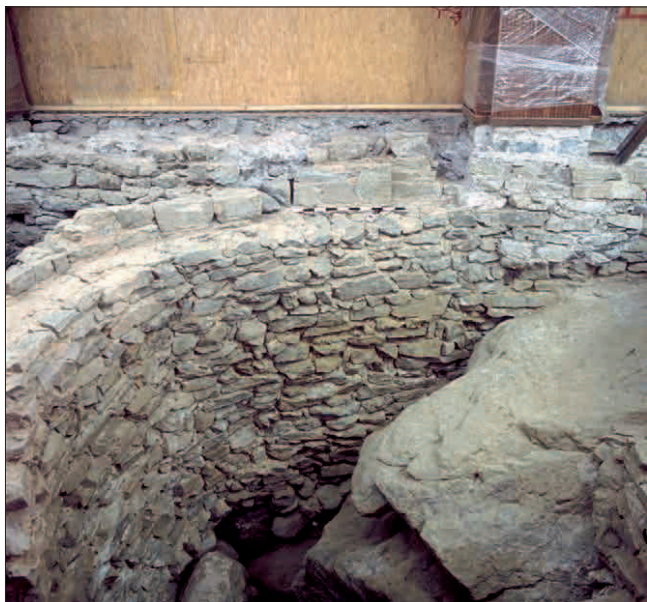
7. Vista da nord di USM 38. (Arsenale)
