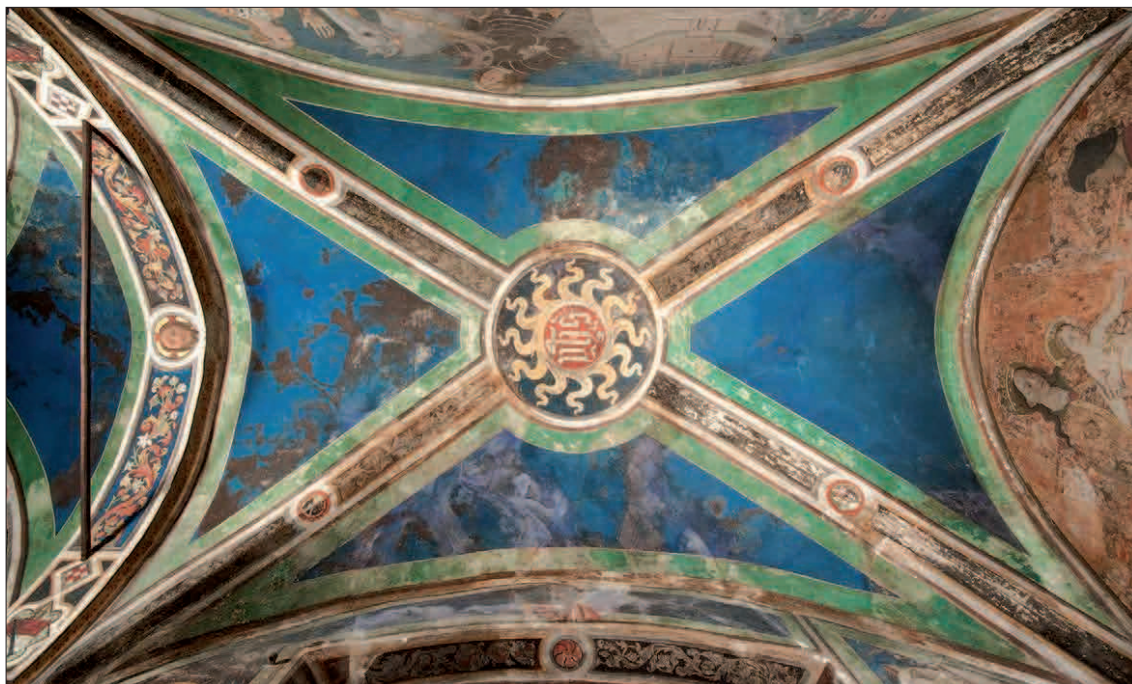
7. Volta a est, prima del restauro. (Pb. Trossello)
