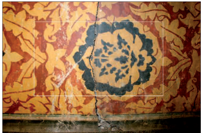
20. Parete nord, zoccolatura, durante la pulitura. (N. Cuaz)
