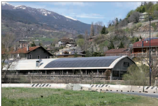
5. Installazione corretta dei pannelli fotovoltaici che seguono la curvatura della copertura dell'edificio sito a margine di un'area industriale. (C.F. Quiriconi)
