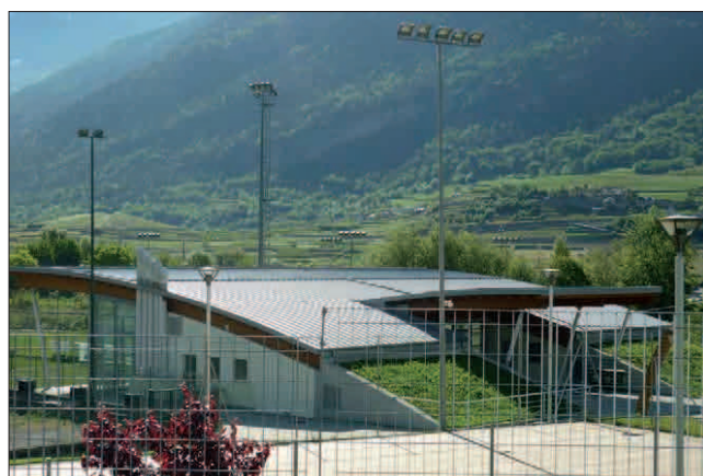
8. Inserimento del fotovoltaico sulla copertura di un'opera pubblica. (C.F. Quiriconi)
