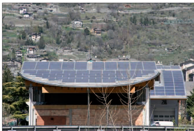
7. Sostituzione del manto di copertura con elementi fotovoltaici in zona artigianale. (C.F. Quiriconi)
