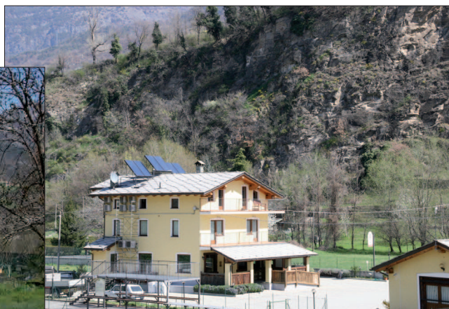
2. Inserimento errato di impianto fotovoltaico su un tetto, in quanto i pannelli dovrebbero essere complanari alla falda. (C.F. Quiriconi)
