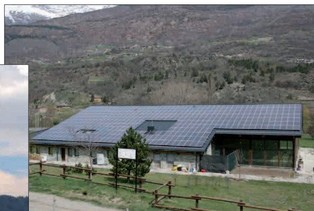
4. Copertura quasi totale del tetto con collettori fotovoltaici su un edificio recente a fianco di una importante infrastruttura. (C.F. Quiriconi)
