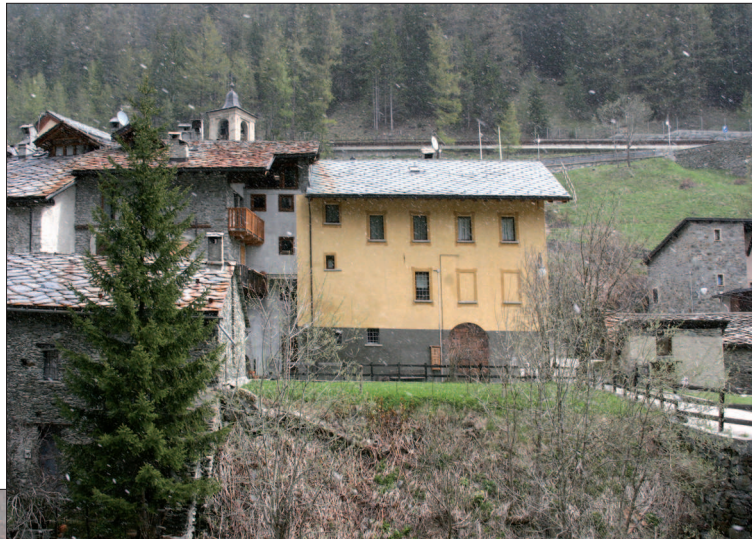
4. Ripristino intonaco di fabbricato storico. (C.F. Quiriconi)
