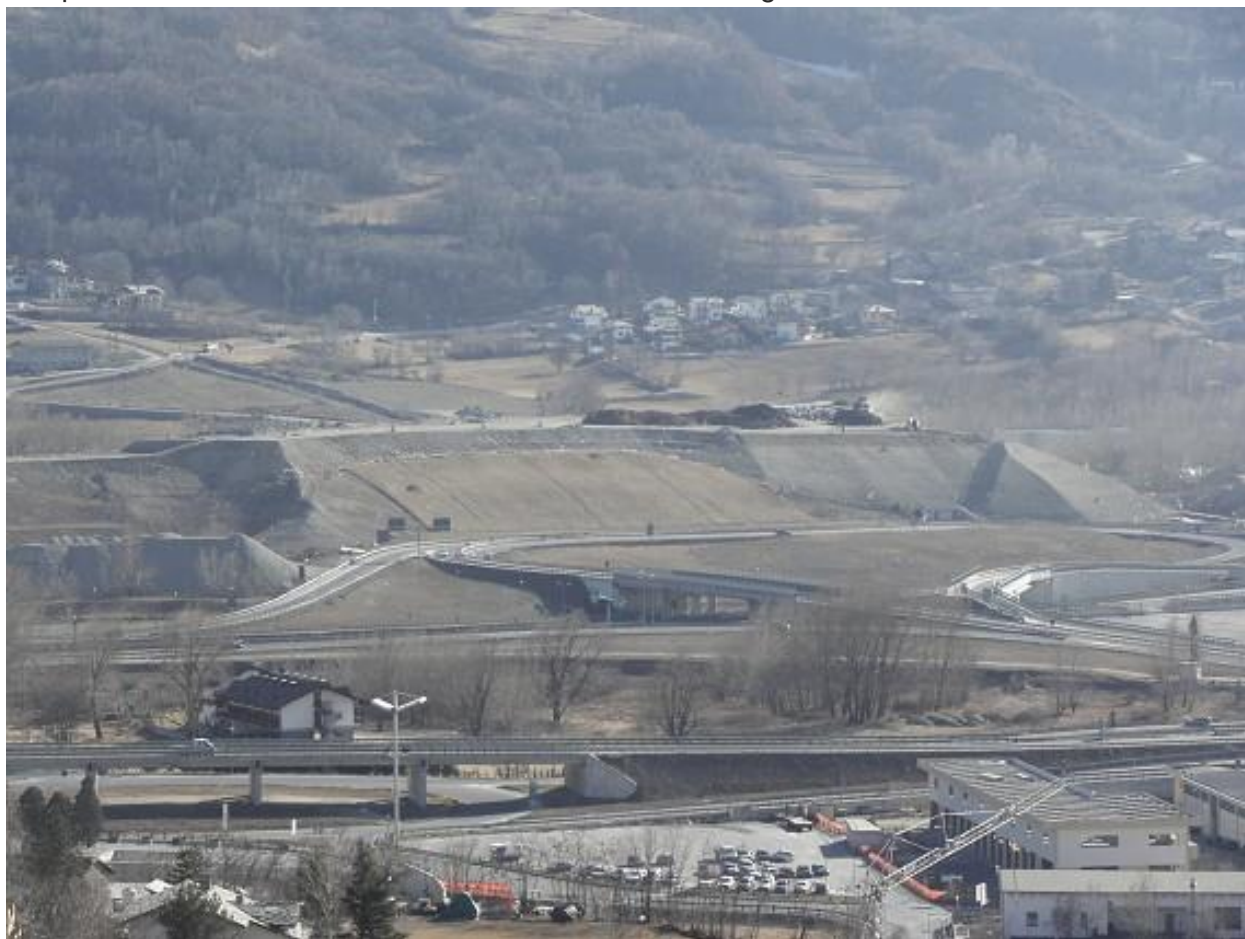
Veduta frontale della discarica di Brissogne
