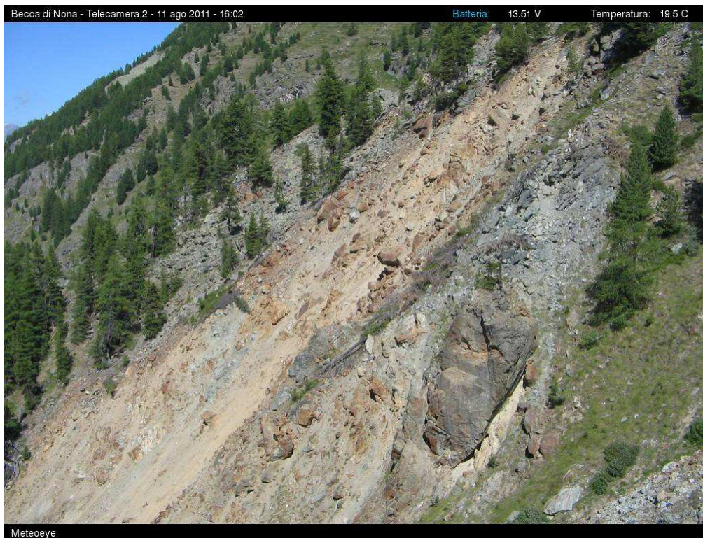
Foto 2: Vista laterale della parte sommitale del canale sinistro
