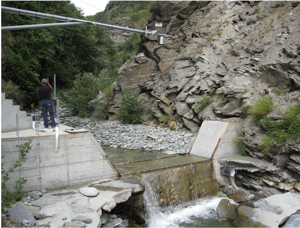
Foto 1: Vista da valle verso monte della stazione idrometrica
