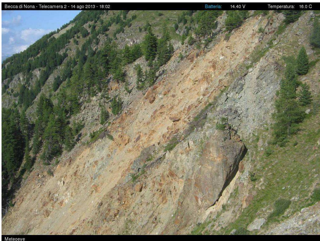
Foto 2: Vista laterale della parte sommitale del canale sinistro
