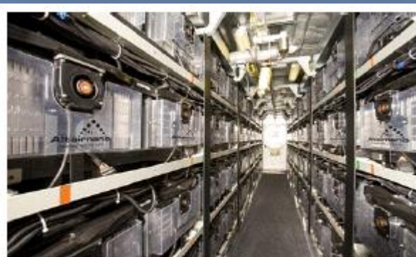
1 MW / 15 min Li-ion
