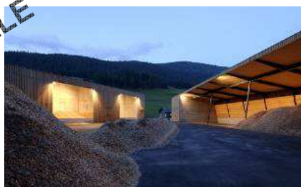
Teleriscaldamento di Sesto
