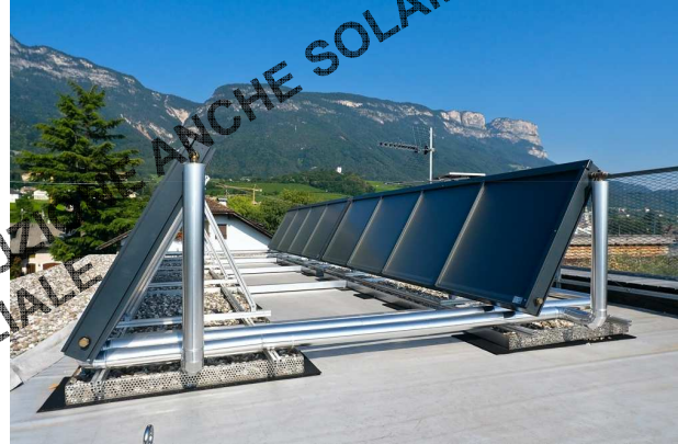
Impianto gastermico (3 - 13kW) + pannelli solari (copertura del fabbisogno acqua calda sanitaria: 67%)
