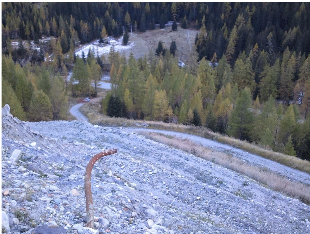
Foto n.1 Zona di accesso.
