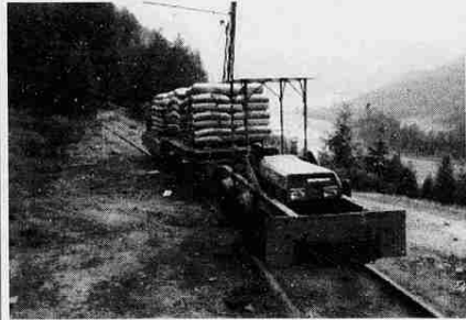
Fra tre anni saranno ultimati i lavori di costruzione della ferrovia Cogné-Acque Freddes-Plan Praz. Nella foto il trasporto di materiali per la linea ferrata
