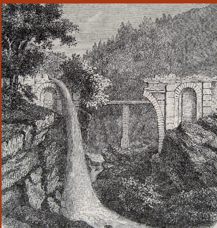
Il ponte dopo il crollo dell'arcata centrale in una veduta di Aubert del 1860 (Aubert 1860, p. 119)
