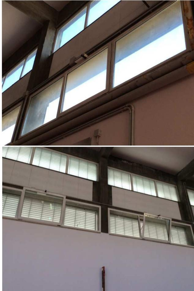
Nell'esempio riportato, la principale inefficienza era dovuta alla tenuta delle finestre a nastro con azionamento elettrico. La motivazione era legata alla non corretta chiusura del meccanismo, facilmente correggibile tramite registrazione del motorino.
