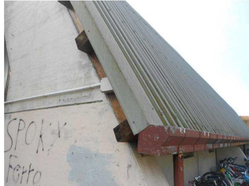
La parete esistente è stata calcolata tramite termoflussimetro con un valore medio al centro del pannello di  $0,45 \text{ W/m}^2\text{K}$ , il valore medio della parete, comprensivo dei ponti termici del pannello prefabbricato e degli innesti tra pannello e pannello, ha portato ad un valore di trasmittanza di  **$0,749 \text{ W/m}^2\text{K}$**
