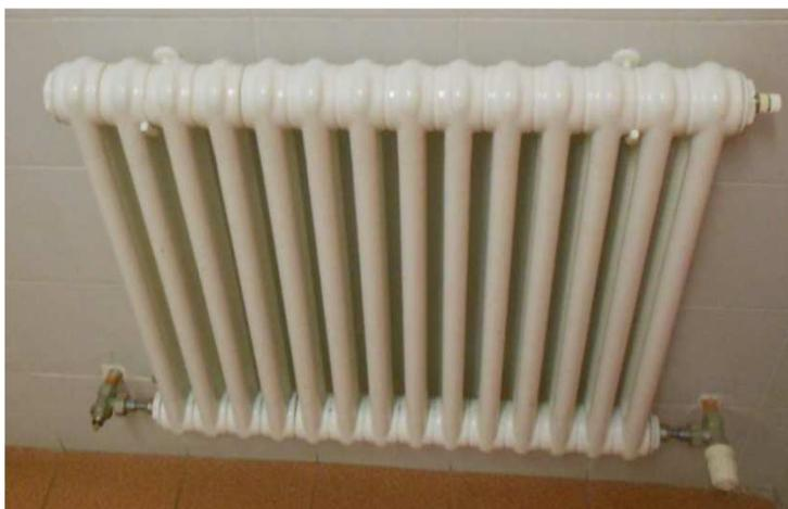
Ove non presenti, come nella foto effettuata nei bagni del fabbricato, risulta conveniente installare le valvole termostatiche al fine di regolare in maniera automatica ambiente per ambiente, la temperatura.
