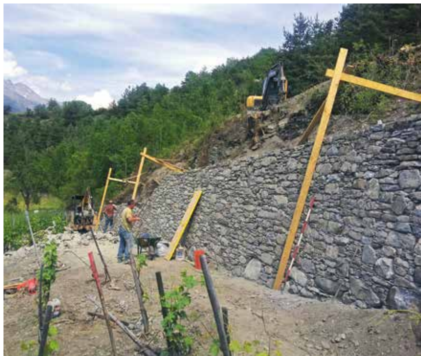
Lavori in località Plan Ru, Gressan, Tappa 19.
