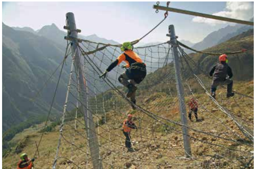
Cantiere paravalanghe in amministrazione diretta – Bionaz, Tza de Noyer.
