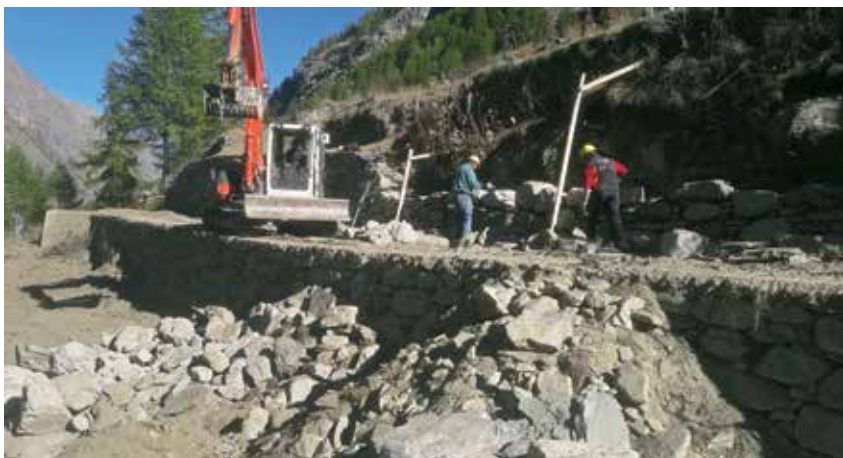
Cantiere in appalto per i lavori di consolidamento di una scarpata - Valsavarenche, Pont du Loup.
