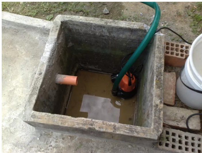
Pozzetto di raccolta delle acque
