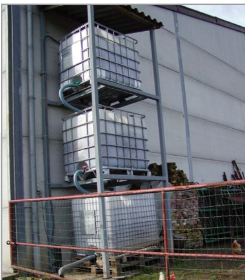
Esempio di biofiltro
