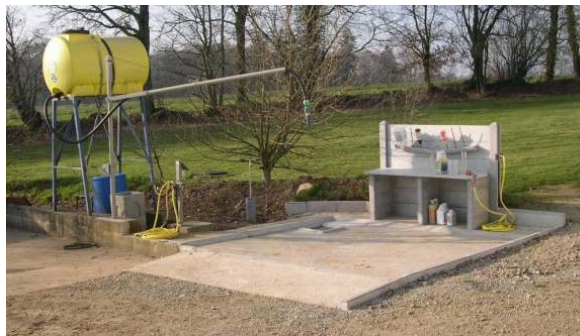
Fig. 3 – Area attrezzata per preparazione della miscela e riempimento dell'irroratrice (foto ARVALIS).
