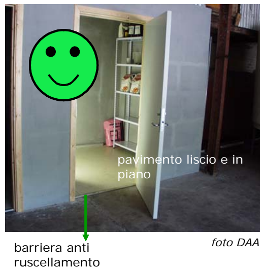
Fig. 13 – Locale per lo stoccaggio degli agrofarmaci dotato di pavimento liscio e barriera antiruscellamento
