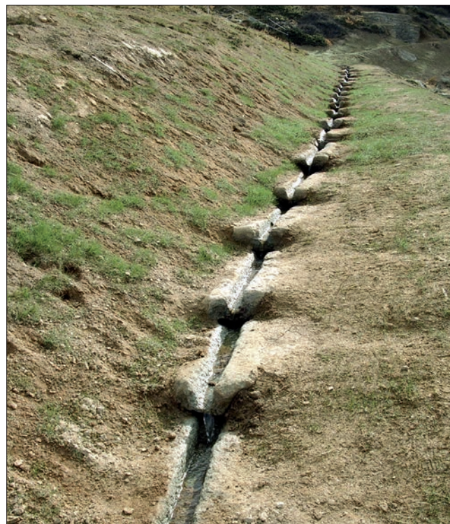
8. Alpe Truc: particolare acquedotto. (D. Martinet)
