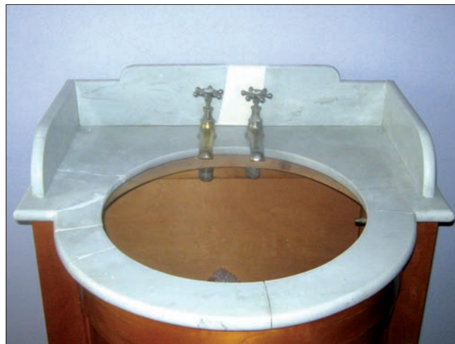
2. Particolare del risarcimento delle lacune nel piano in marmo. (G. Furnari)
