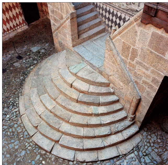
1.-2. La scala prima e dopo l'intervento. (S. Pulga)
