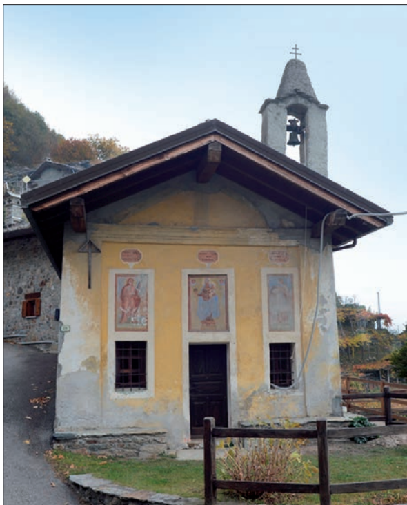
1. La facciata prima dei lavori (N. Pozzato)
