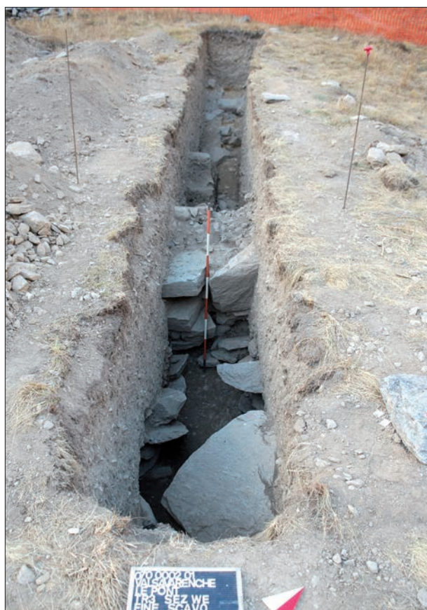
17. Il potente muro di terrazzamento e il suo crollo emerso nella trincea 1. (D. Wicks)
