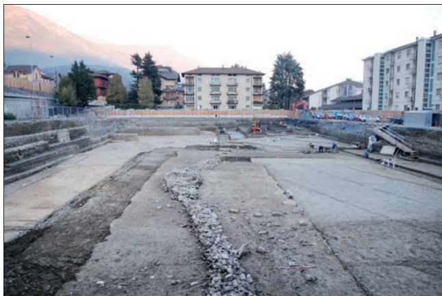
22. Il muraglione della fase IX costruito dopo il primo debris-flow. (P. Gabriele)
