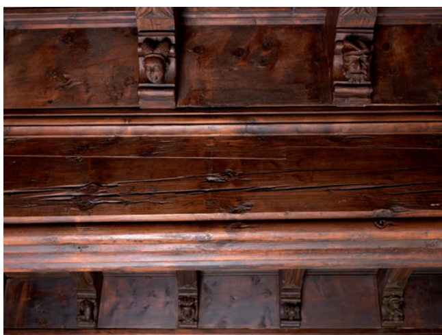
7. Dettaglio del soffitto con il punto di contatto a saetta della trave sovrapposta. (D. Cesare)
