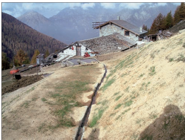
7. Alpe Truc: abbeveratoi e acquedotto. (D. Martinet)
