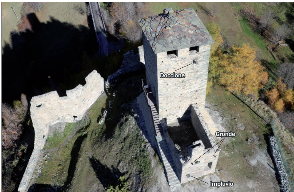
8. Il mastio e l'edificio annesso a sud: in evidenza il sistema di recupero dell'acqua piovana. (D. Sepio)
