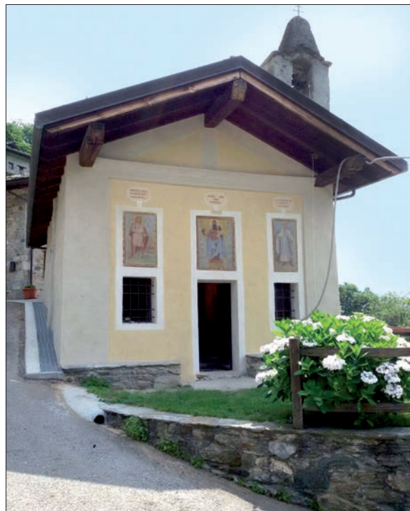
2. La facciata dopo il restauro. (G. Adesso)
