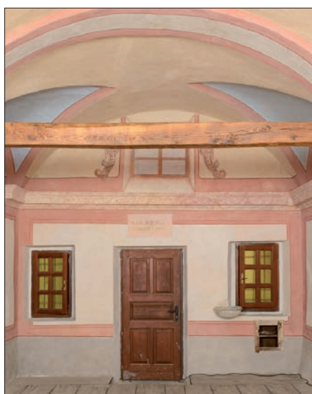
5. La controfacciata dopo i lavori. (N. Pozzato)
