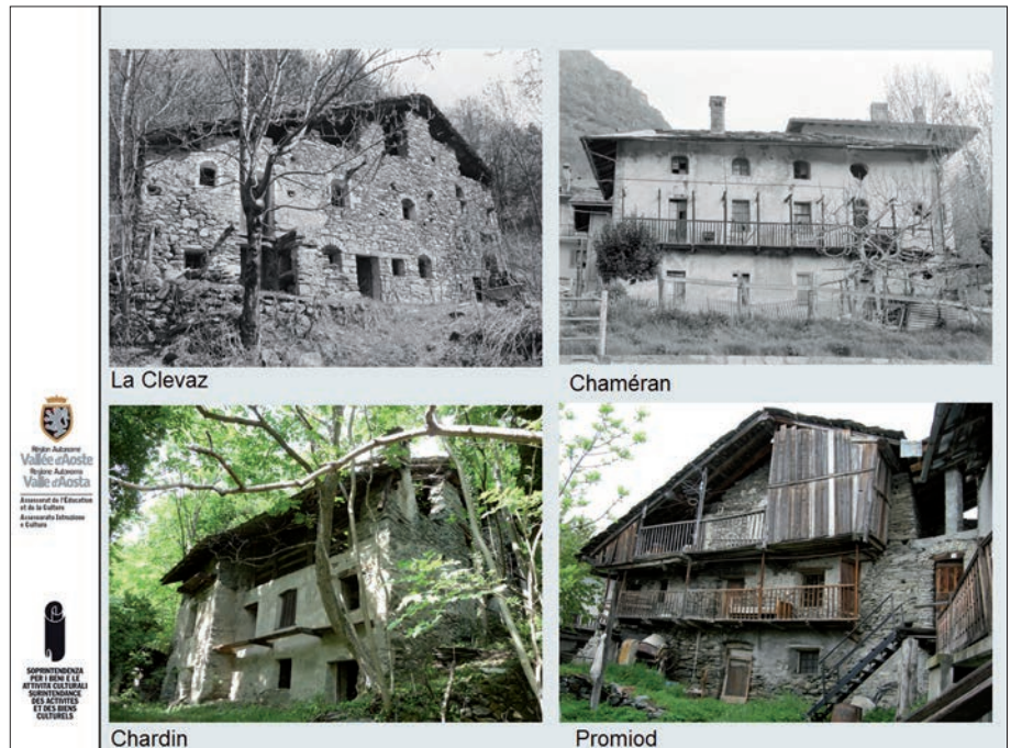
5. Edifici con varie tipologie di aperture.
