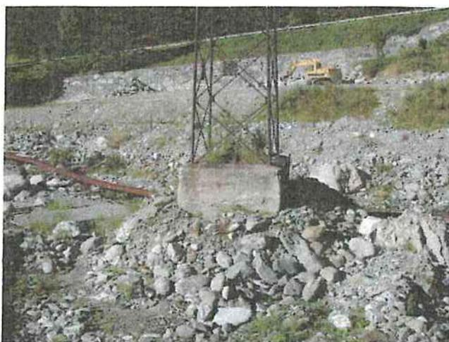
Figura 2 – Due particolari degli effetti sui tralicci P.3B (in alto) e Ex 1 (in basso) in seguito al fenomeno di divagazione ed erosione da parte del Torrente Marmore.
