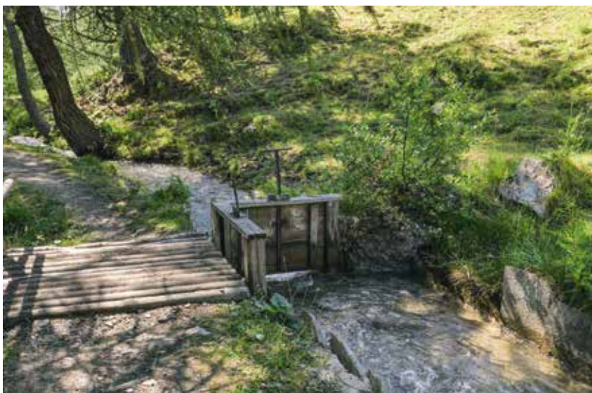
Derivazione sul Ru de By, intervento del Consorzio che gestisce il canale
