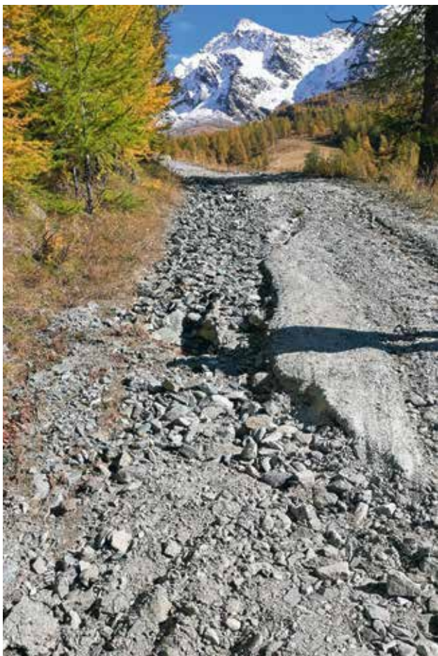
Viabilità di accesso al villaggio di Resy - zona Bettaforca nel Comune di Ayas, interessata da ruscellamenti incontrollati ed erosioni del piano viabile
