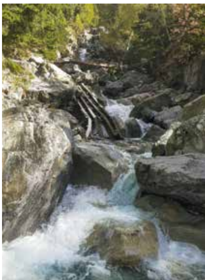
Il ponte sul Loobach nel Comune di Gressoney-Saint-Jean, divelto dall'evento di piena
