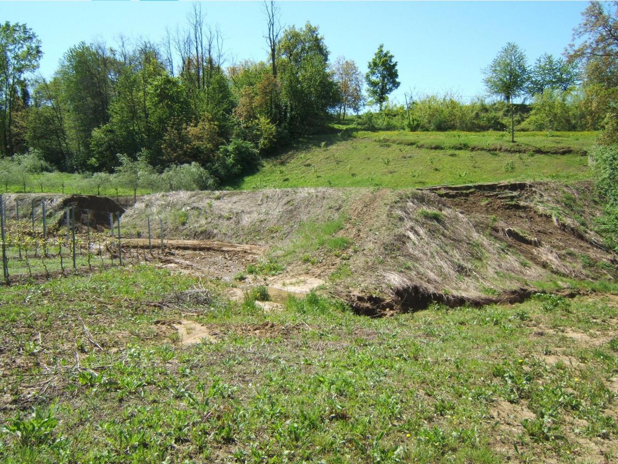
**Invaso con problemi di stabilità del versante, rottura del corpo diga e scivolamento sul paramento esterno dello sbarramento in un altro punto.**
