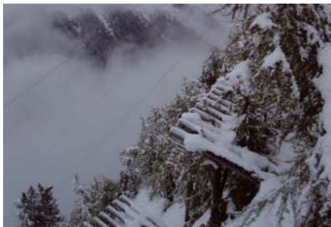
Figura 4.4 Rastrelliere da neve in legname realizzate a Davos (Svizzera).
