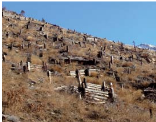
Figura 2.19 Utilizzo della necromassa bruciata per la mitigazione dei pericoli naturali (17 marzo 1997 - Morgex, Valle d'Aosta).
