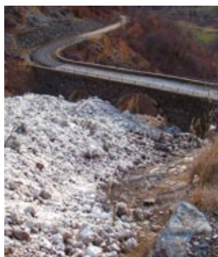
Valanga primaverile che ha interessato la viabilità a Novalesa (Torino)
