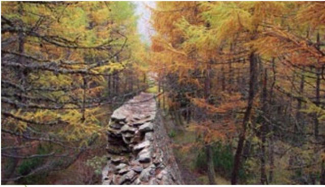
Deviatori di valanga a Saint-Rhémy (Valle d'Aosta - 1841): a pettine parzialmente crollato (sinistra) e a cuneo (destra)
