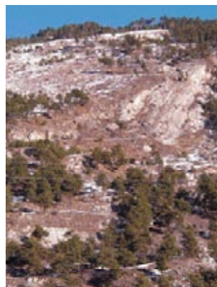
Zona di distacco massi al limite del bosco
