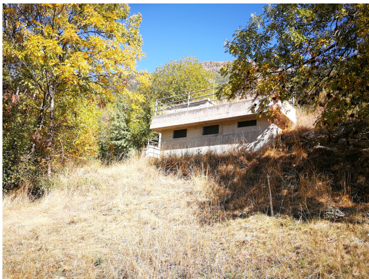
Opera di captazione esistente in parte interrata da ampliare con la realizzazione della centralina idroelettrica
