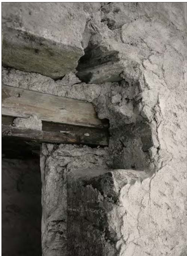
7. Angolo superiore destro della finestra inferiore: risultano evidenti le tracce di rimozione dello stipite occidentale e dell'architrave, così come le travi lignee della camera interna. (N. Cuaz)
