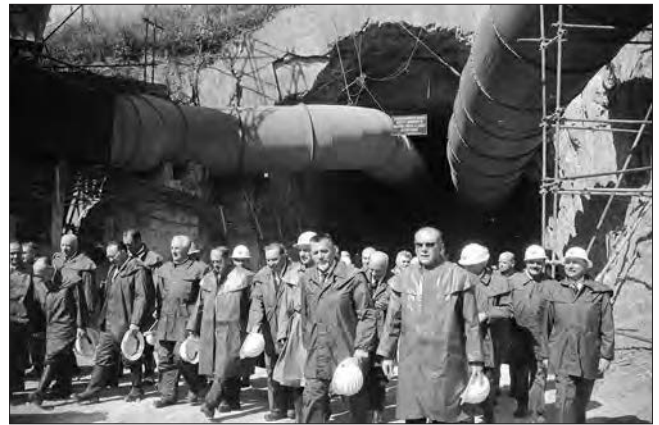
33. Courmayeur (loc. Entrèves), 15 settembre 1961. Perforazione del traforo del Monte Bianco sotto la direzione del conte Dino Lora Totino. Visita dei ministri al cantiere. (O. Bérard, fondo Bérard, CC BY-NC-ND)
