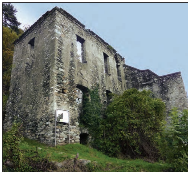
1. L'edificio visto da ovest, in primo piano il fabbricato 2 prima dell'intervento.
