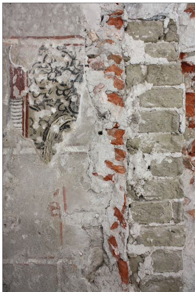
9. Rifacimento in mattoni crudi dello stipite sinistro (orientale) della finestra inferiore. (G. Sartorio)
