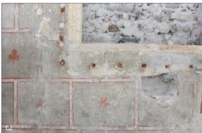
21a.-b. Angolo inferiore sinistro della finestra crociata: gli stipiti lapidei, la tamponatura e il paramento a finti conci prima e dopo il restauro. (N. Cuaz)
