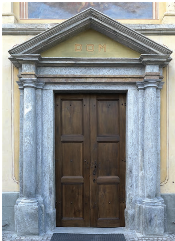
2. Il portale al termine dell'intervento. (D. Cesare)
