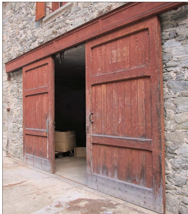
2. Il portone scorrevole oggetto di restauro che fungerà da ingresso. (N. Dufour)
