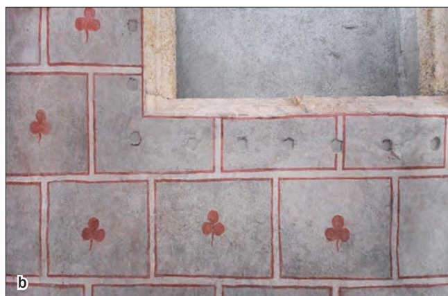
21a.-b. Angolo inferiore sinistro della finestra crociata: gli stipiti lapidei, la tamponatura e il paramento a finti conci prima e dopo il restauro. (N. Cuaz)
