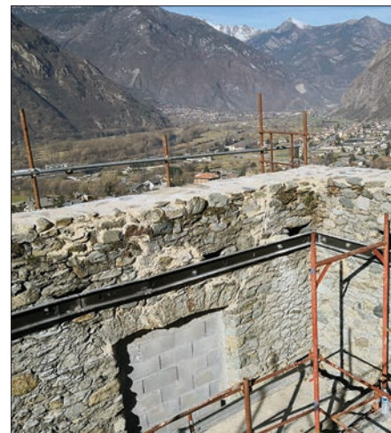
3. Angolo ovest del fabbricato 2. Particolare ancoraggio interno e restauro parte sommitale durante l'intervento. (C. Avantey)
