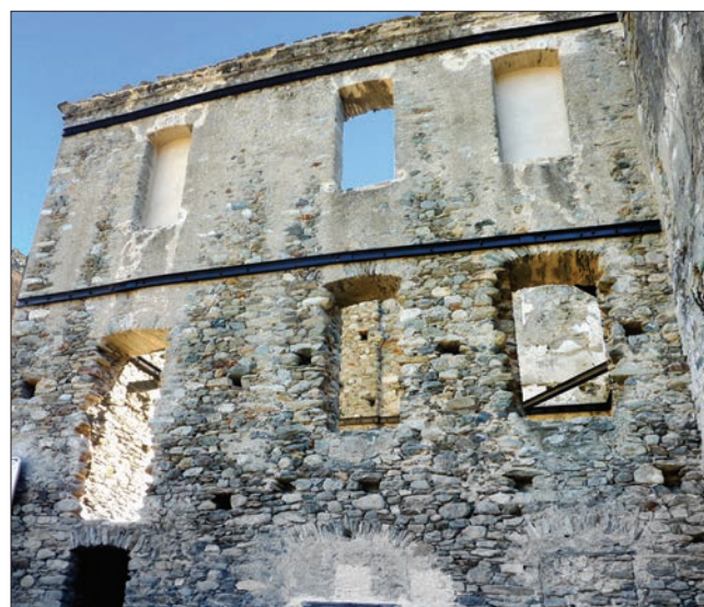
5. Facciata ovest del fabbricato 2 a intervento ultimato. (C. Avantey)
