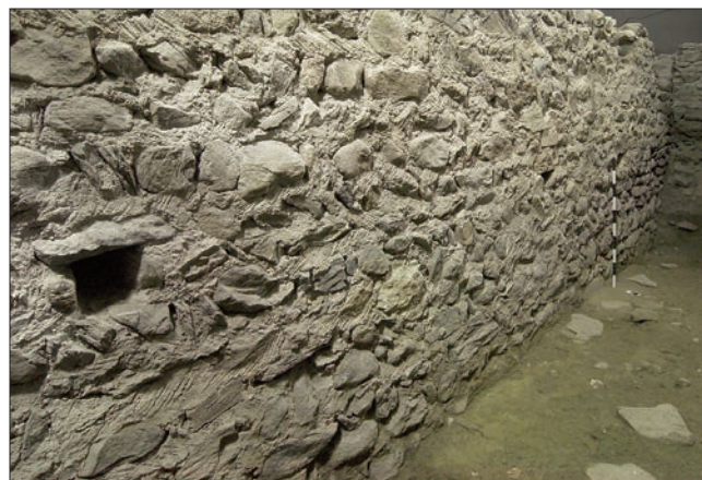
13. Struttura USM 1570: in evidenza la particolare finitura del prospetto meridionale. (S.E. Zanelli)
