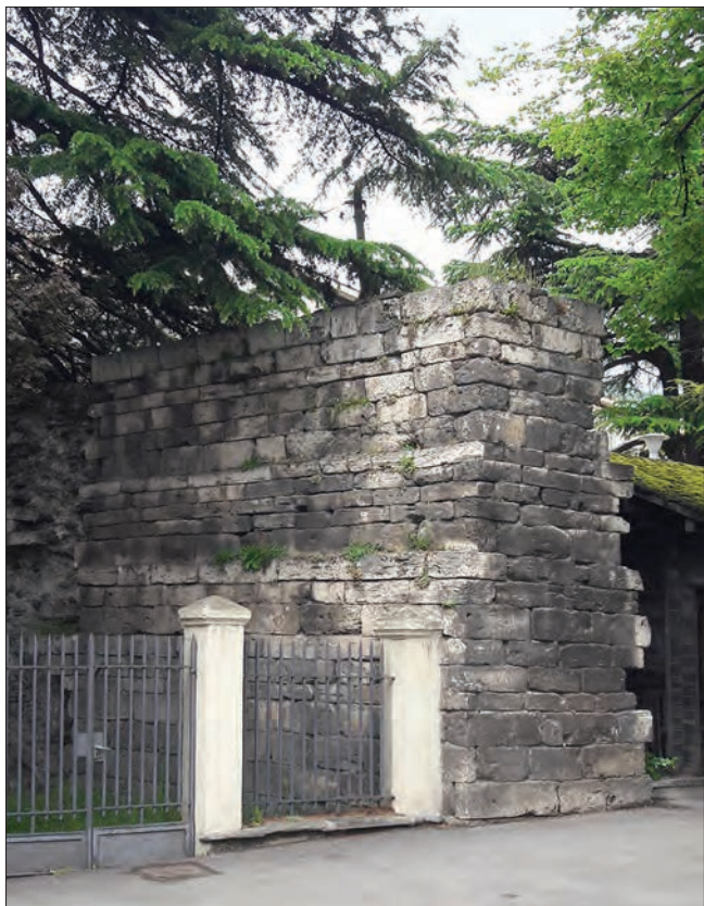
4. Breccia aperta nella cinta e rivestita col materiale originario romano. (M.C. Fazari)
