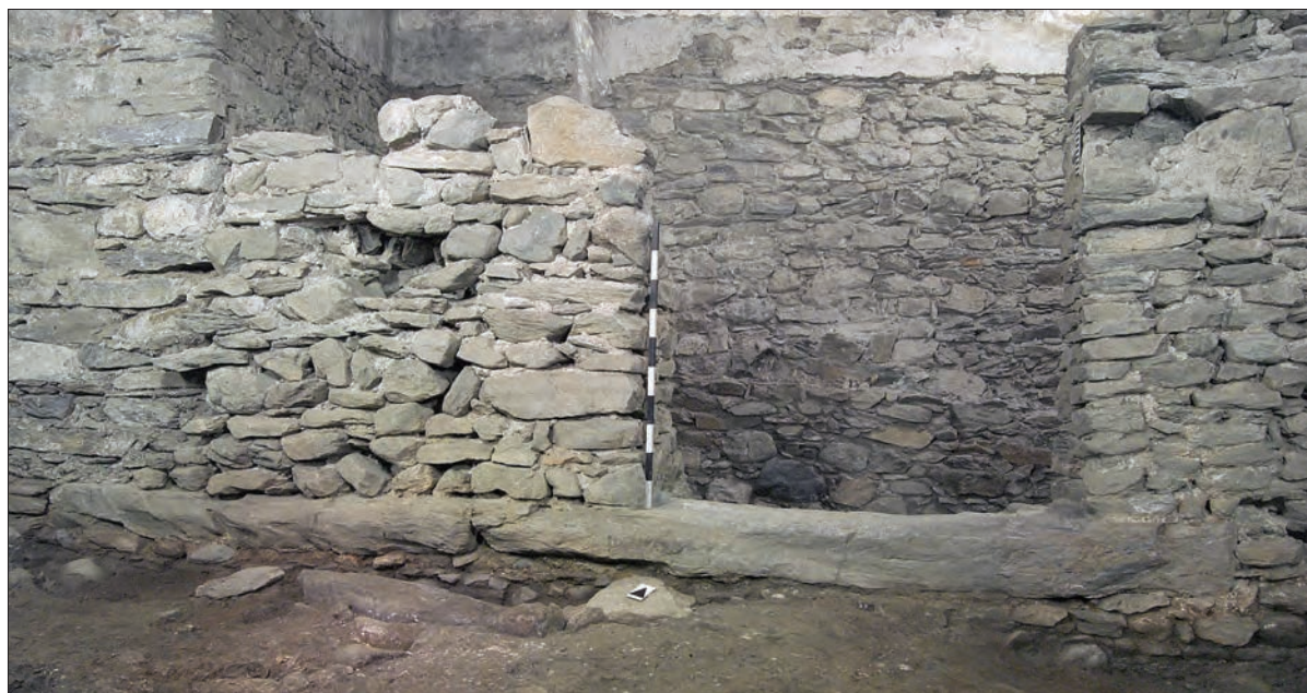
19. Soglie in bardiglio del portale di accesso all'atrio occidentale. (S.E. Zanelli)
