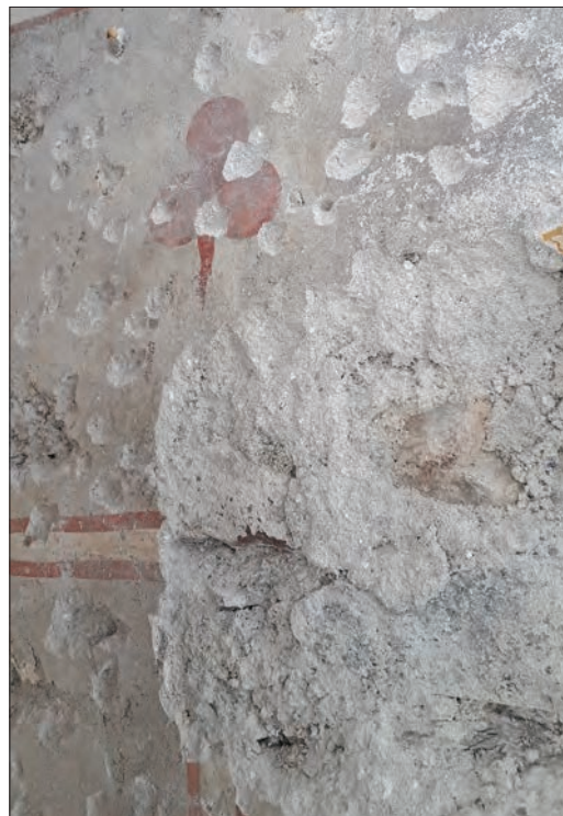
16. Stato di conservazione dell'apparato dipinto a finti conci, dopo la rimozione degli intonaci sovrammessi. (N. Cua?)
