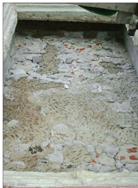
19. Muratura che chiude la finestra superiore, prima della stesura dello strato di finitura. (N. Cuaż)
