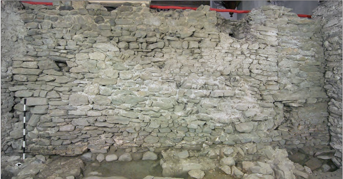
20. Parete est dell'atrio occidentale: a destra la porta d'accesso all'annesso meridionale, riaperta in occasione dei recenti restauri. (S.E. Zanelli)
