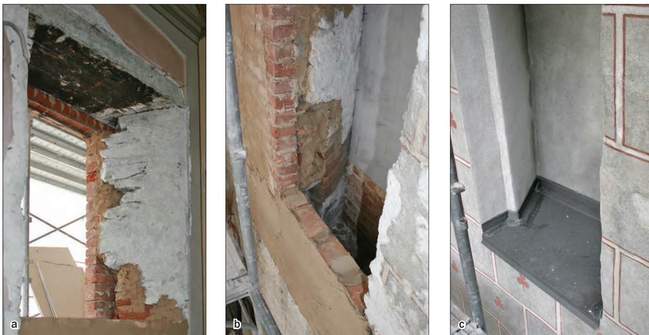
18a.-c. Fasi della tamponatura della finestra inferiore. (N. Cuaż)
