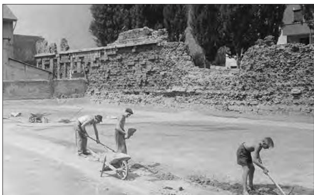
16. Lavori di sistemazione del lato meridionale esterno della cinta muraria romana, anno 1953. (Archivio beni archeologici)
