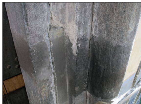
4. Dettaglio durante la rimozione delle ridipinture. (C. Béthaz)
