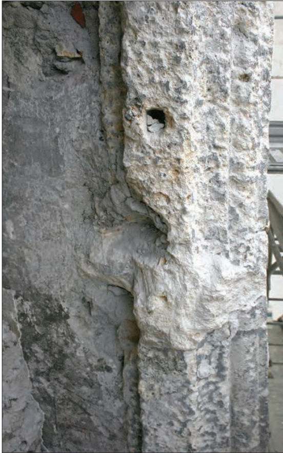
13. Punto della finestra superiore in cui il braccio orizzontale della croce, poi rimosso, si inseriva nello stipite occidentale. (N. Cuaz)
