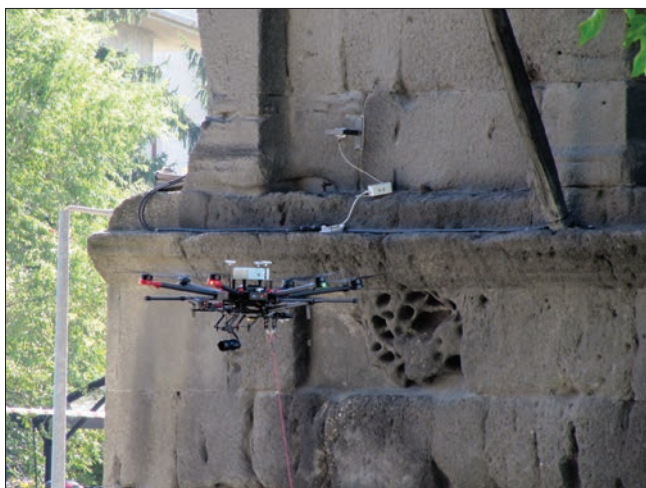
2. Particolare del drone durante un rilievo fotogrammetrico all'Arco di Augusto. Nello sfondo si può osservare la centralina della rete di sensori SMART, ubicata all'interno del fornice del monumento. (OAVdA)
