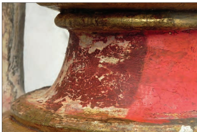
17. Dettaglio della base della colonna durante la rimozione della ridipintura più recente. (G. Zordan)
