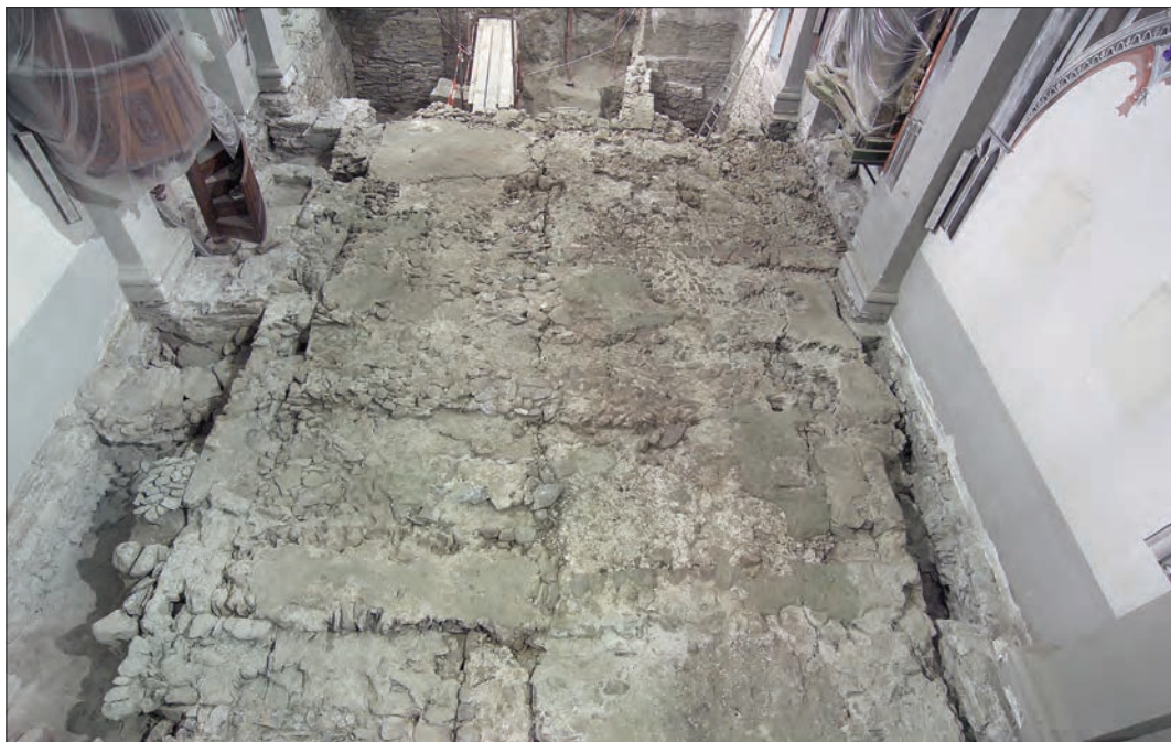
25. Pavimentazione in cocciopesto della chiesa superiore, al di sopra delle volte della cripta. (S.E. Zanelli)
