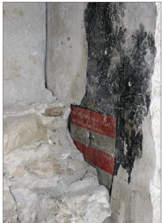
15. La rimozione del tamponamento dalla finestra inferiore rivela la decorazione murale sullo sguancio occidentale. (N. Cuaz)
