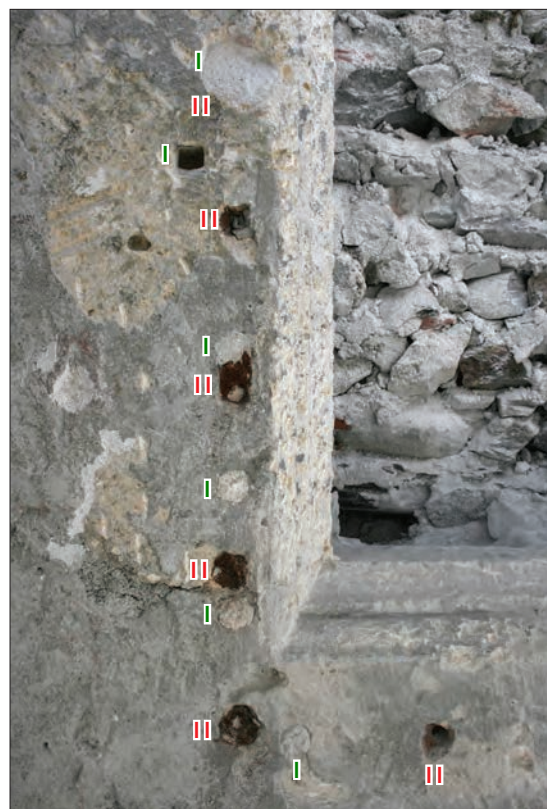
6. Angolo inferiore sinistro della finestra crociata: fori per l'alloggiamento dell'inferriate in fase I e II. (N. Cuaꝛ, elaborazione L. Caserta, G. Sartorio)
