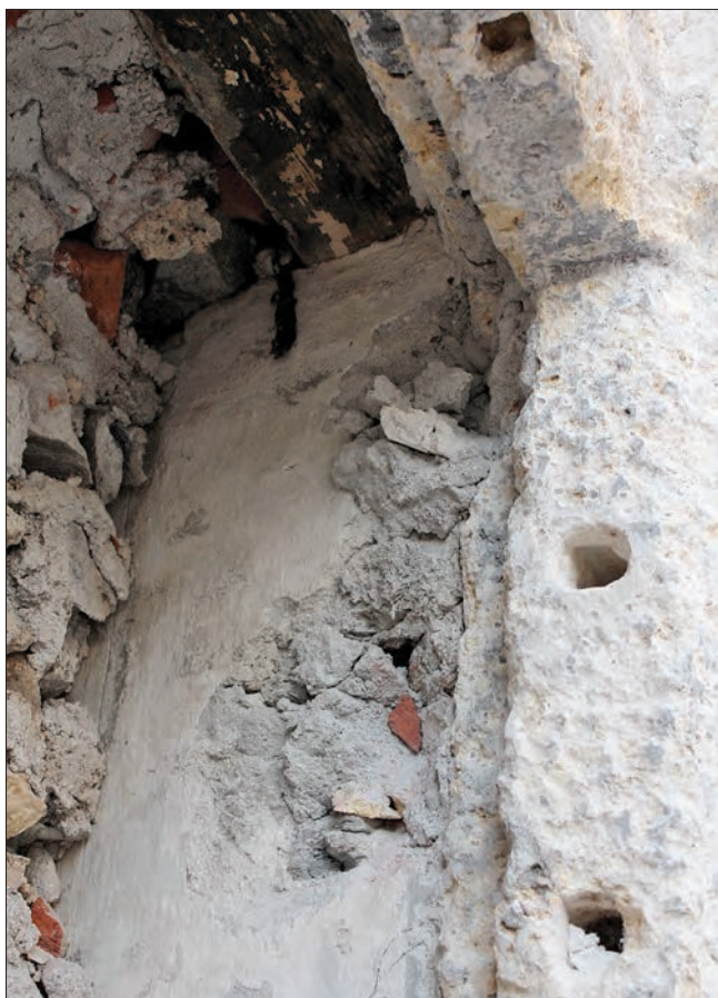
3. Vista dell'interno della finestra superiore. (N. Cuaaz)
