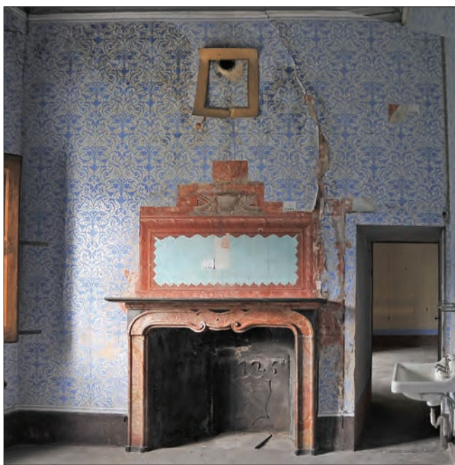
25. Sala ecclesiastica. Particolare della parete est prima dei lavori di restauro. Si noti la rimozione della carta da parati e i saggi stratigrafici effettuati al di sopra del camino, fotografia del 2009. (F. Filippi)
