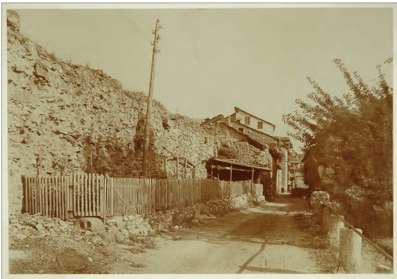
1. Le mura romane nella parte settentrionale di via Vevey alla fine del XIX secolo. (Archivi beni archeologici)
