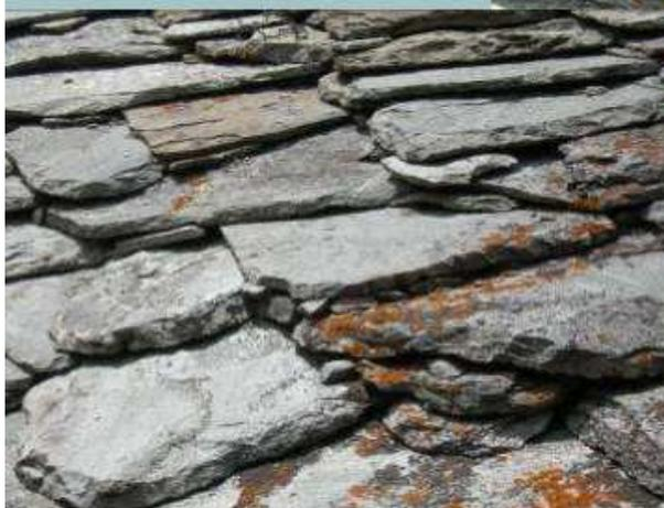
Scaglie servono a stabilizzare le lose di diverse spessore, conferendo al tetto stabilità e impermeabilità
