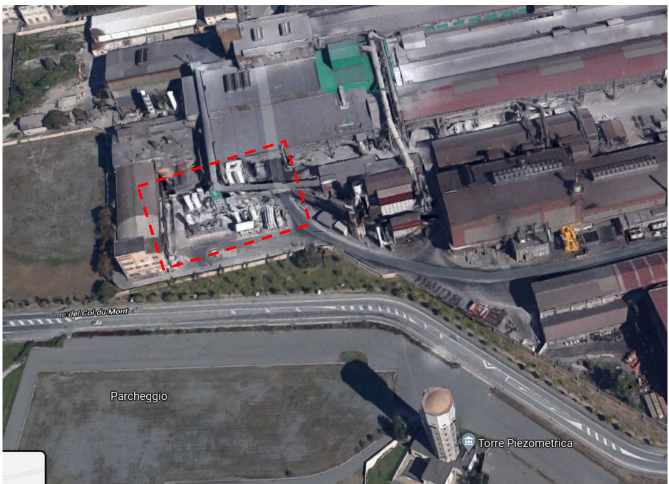
Impianto di stoccaggio Ossigeno
