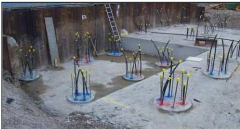
Una soluzione innovativa (almeno per l'Italia) la propone **Geothermal International Italia** con sonde geotermiche inserite direttamente nei **pali da fondazione degli edifici in costruzione**.
