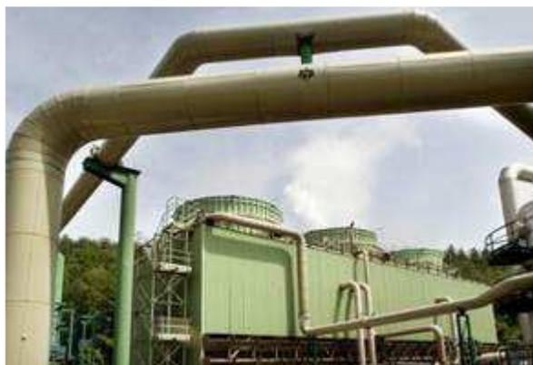
Per la prima volta in Italia, un giacimento geotermico verrà utilizzato con un **sistema chiuso**, basato cioè su due pozzi, il primo per l'estrazione dell'acqua calda, il secondo per la sua reimmissione - dopo l'uso - nel sottosuolo.
