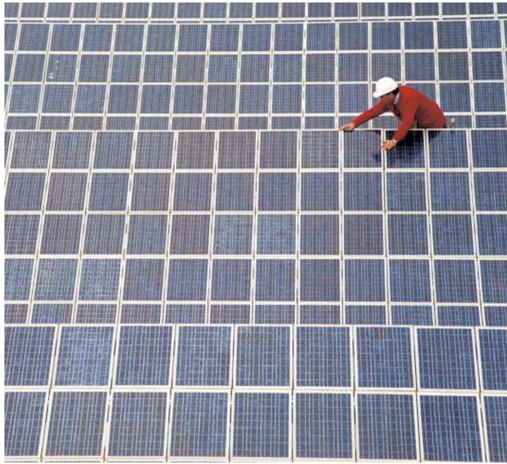
Un impianto di produzione di energia solare
