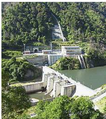
Una centrale idroelettrica
