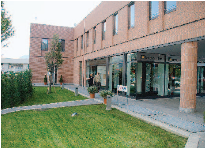
La nuova sede della Cooperativa elettrica Gignod in località Grand Chemin di St-Christophe
