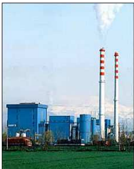
Impianto di teleriscaldamento in provincia di Lecco
