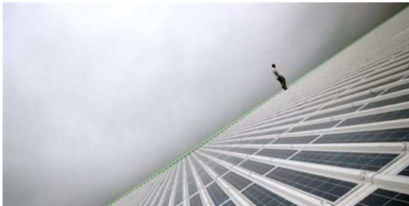
Des panneaux photovoltaïques sur le toit d'une
