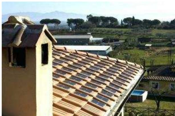
**Moduli per integrazione architettonica del fotovoltaico**
