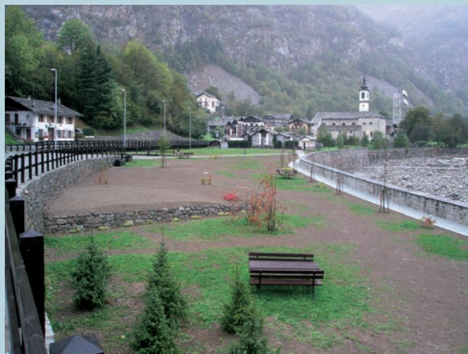
Issime: recupero ambientale dell'area adiacente al torrente Lys
