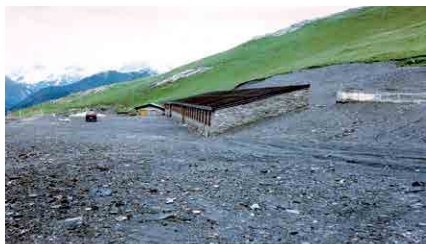
Tramouail Des Ors-damon - m 2385 s.l.m. - ristrutturazione anno 1993
