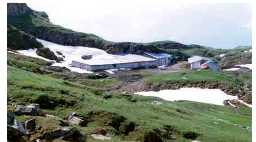
Tsa Bonalé - m 2343 s.l.m. - ante ristrutturazione anno 1996
