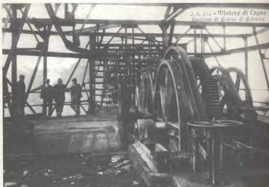
Cogne, complesso minerario di Colonna. (m. 2046) La stazione di carico della teleferica
