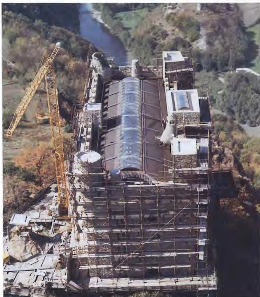
Il castello di Ussel durante i lavori di restauro - Foto prop. R.A.V.A.
