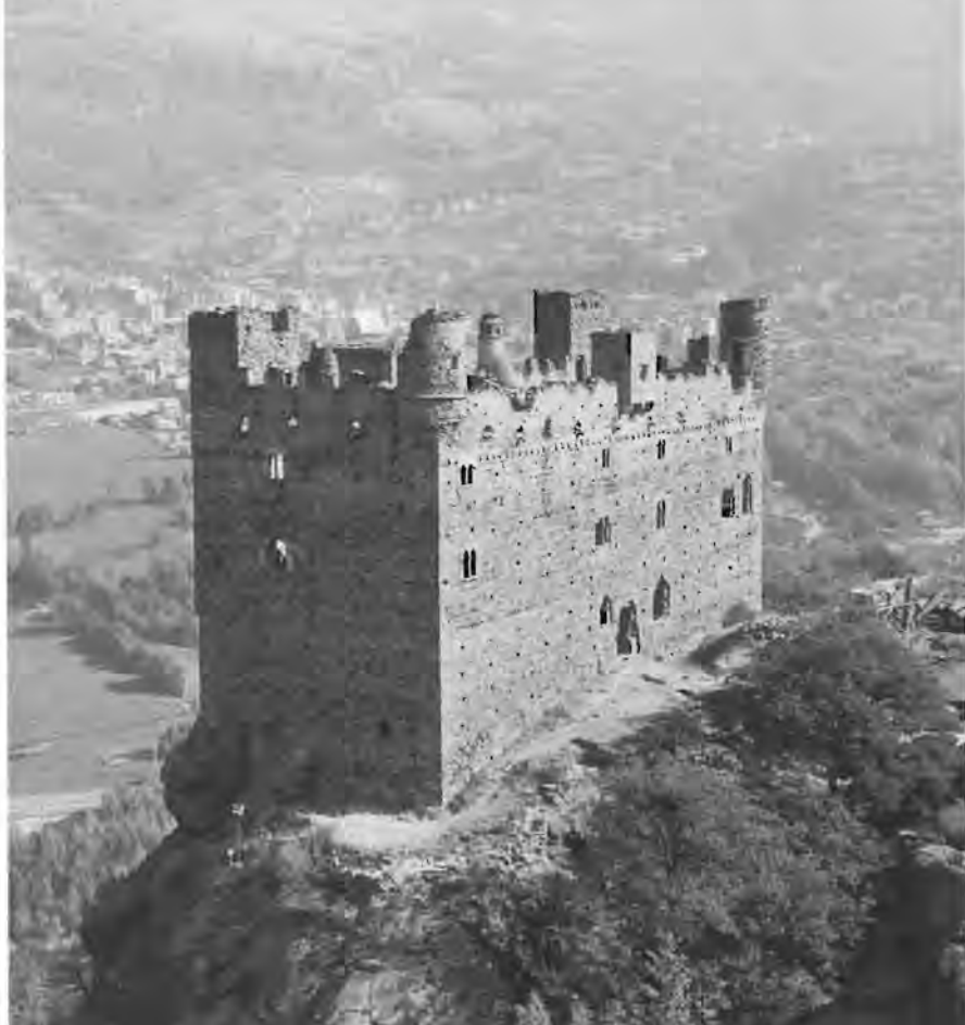
Il castello di Ussel prima dei restauri - Foto prop. R.A.V.A.
