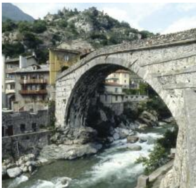
Ponte romano, Pont-Saint-Martin
